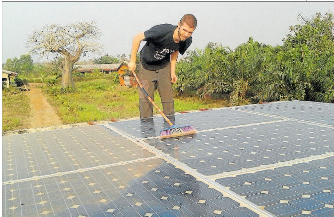
Albert Babí, graduat i TIC, deixant a punt la darrera tongada de plaques fotovoltaïques
