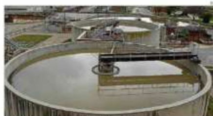
Imatge de l'estació depuradora de Manresa
