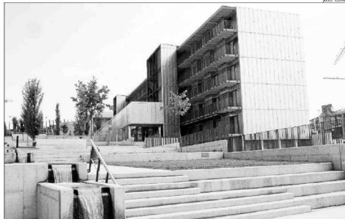
La residència per a estudiants s'ha construït a l'avinguda Universitària, tocant a la FUB
