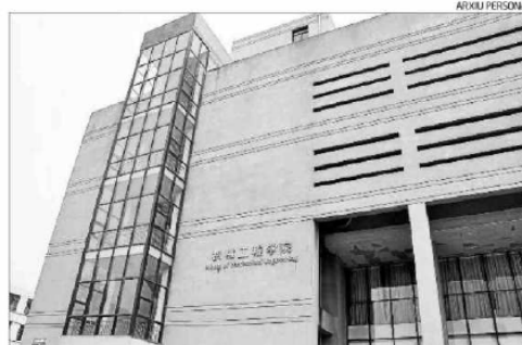
Façana de l'edifici de la Universitat de Ciència i Tecnologia de Nanjing
